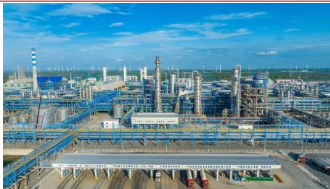
图 17：卫星化学连云港石化烯烃综合利用项目
